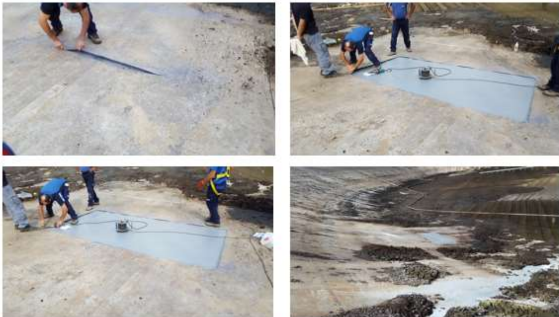
Figura 15. Reposición de material en geomembrana de PVC-P
