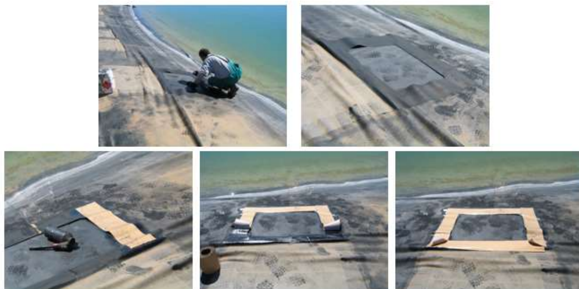
Figura 17. Reposición de material en geomembrana de EPDM
