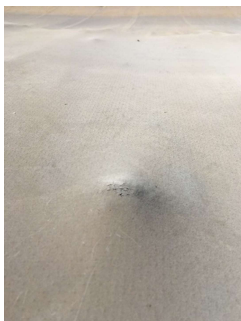
Figura 28. Punzonamiento incipiente en lámina de PVC armada
