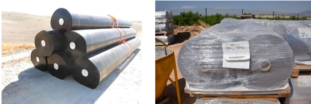
Figura 33. Acopio de geomembranas para impermeabilización
