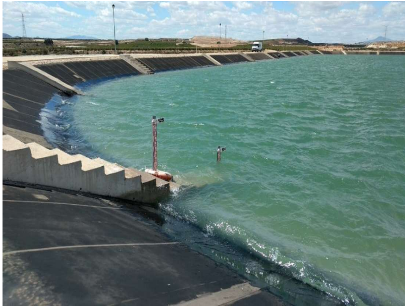
Figura 45. Efectos del oleaje en la balsa
