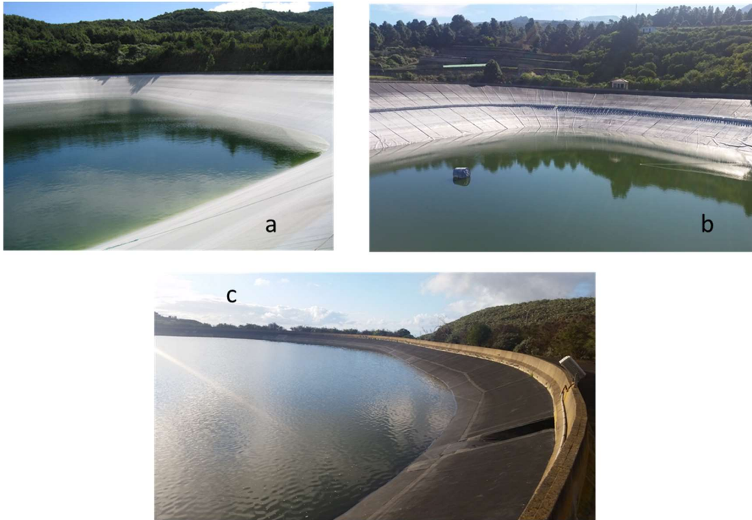
Figura 1. Ejemplos de balsas impermeabilizadas con geomembranas de PVC (a), PE (b) y EPDM (c)
