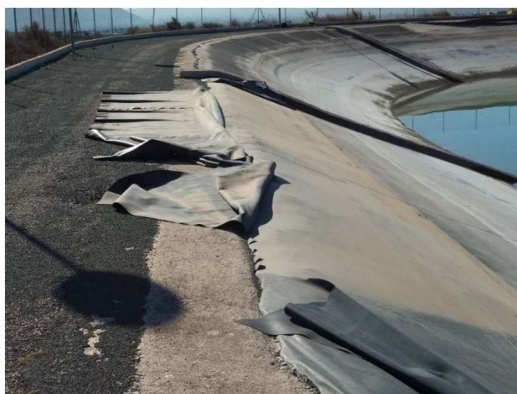
Figura 44. Levantamiento del babero por la acción del viento
